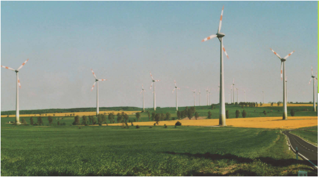
In einem Agrargebiet installierte Windkraftanlagen (Aufn.: M. Görner)
