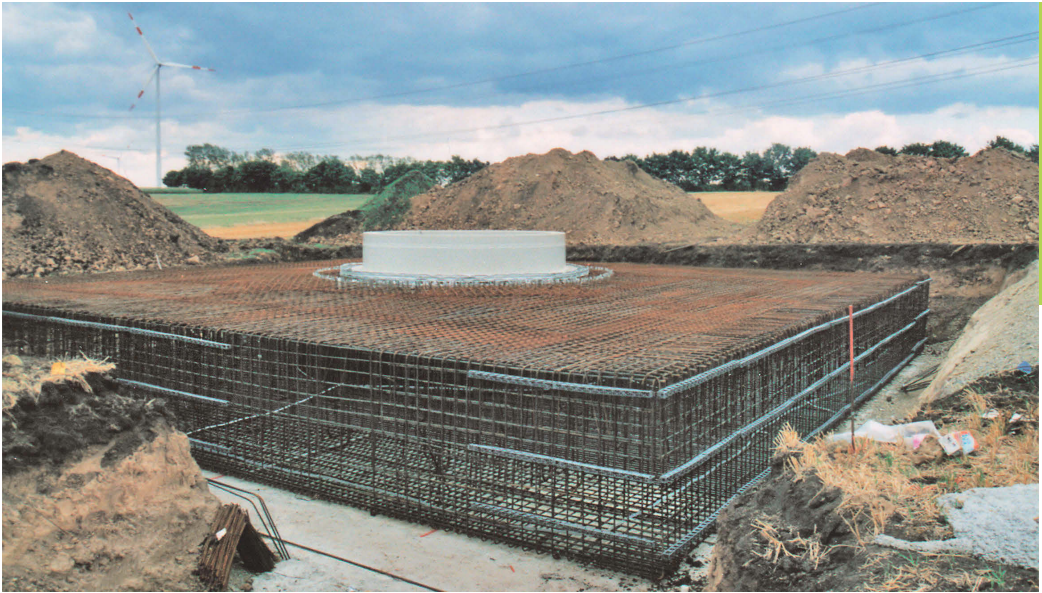
Beispiel für ein Fundament einer Windkraftanlage im Offenland (Aufn.: K. Maltzahn)
