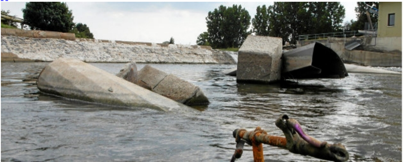
Hochwasserschäden am Debschwitzer Wehr, aufgenommen im Juli 2013 Foto: Jan Dressel
